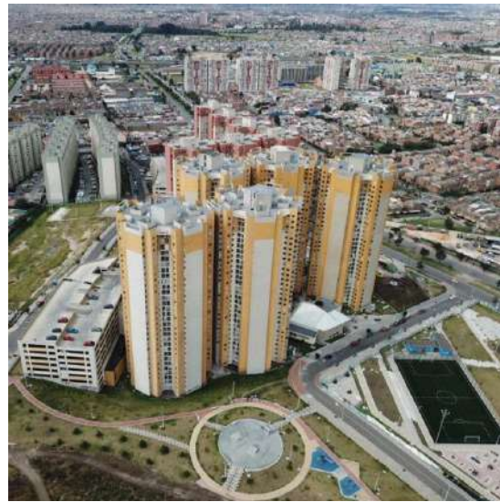
FIG. 8 Vista aérea del Conjunto Residencia Torres de Bellavista, Foto tomada mediante dron por Cruz, Juan A.
